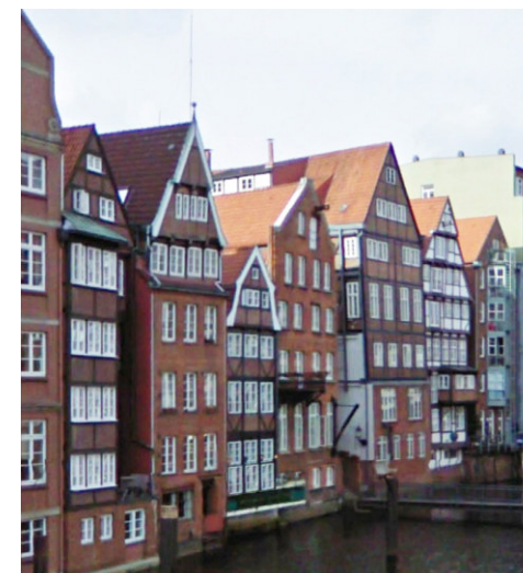
Abb. 21: Variierende Fassadenbilder an der Nicolaifleet in Hamburg
