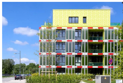
Abb. 127: Bioenergiefassade mit Mikroalgen (Splitterwerk Architekten, IBA Hamburg)
