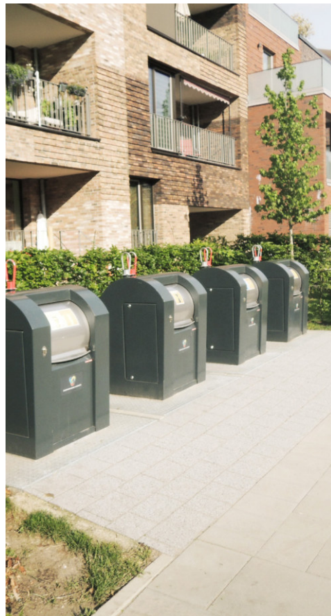
Abb. 116: Unterflursysteme im Außenraum integriert
