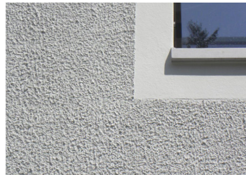
Abb. 29: Strukturierte Putzfassade auf massivem Ziegelbau
