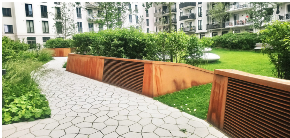
Abb. 119: Gestalterisch integrierte, begrünte Lüftungsöffnungen
