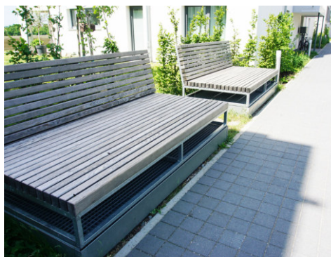
Abb. 118: Mit Sitzmöbel kombinierte Lüftungsöffnung
