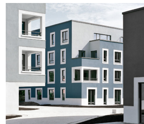
Abb. 41: Integrierte Loggien und Dachterrassen mit massiver Brüstung
