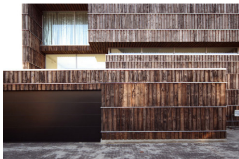
Abb. 126: Recyclingholz aus alten Kabeltrommeln als Fassadenmaterial (2012 Architekten)
