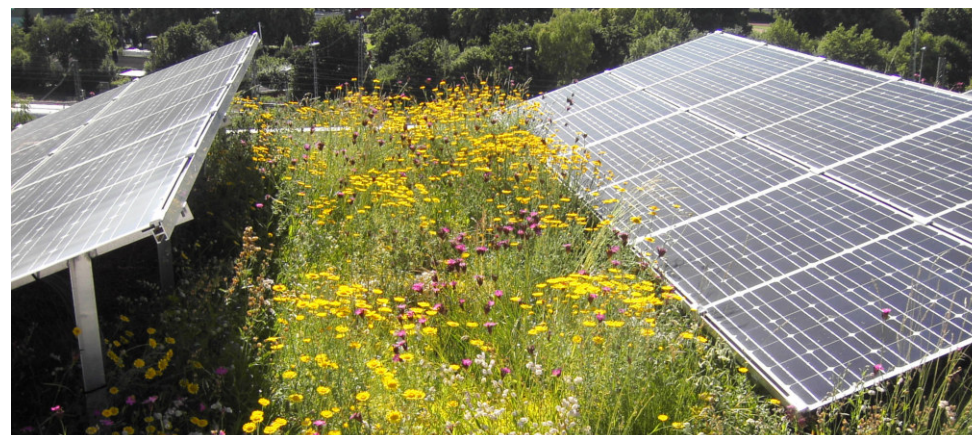
Abb. 54: Extensives Gründach mit kombinierter Energiegewinnung
