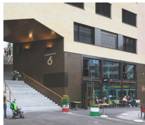
Abb. 195: Hohe, dunkle Sockelzone (Kalkbreite, Zürich)
