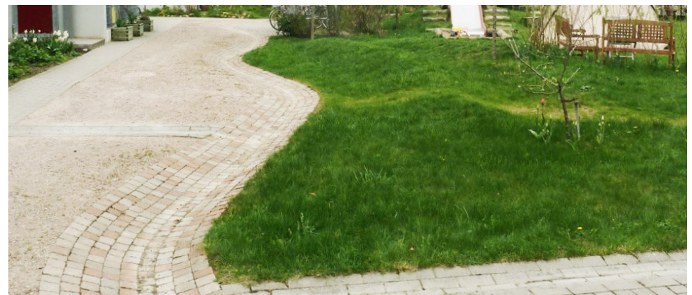
Abb. 110: Pflasterrinne entlang von Hofwegen
