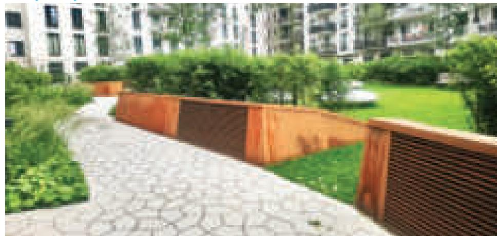
Abb. 119: Gestalterisch integrierte, begrünte Lüftungsöffnungen
