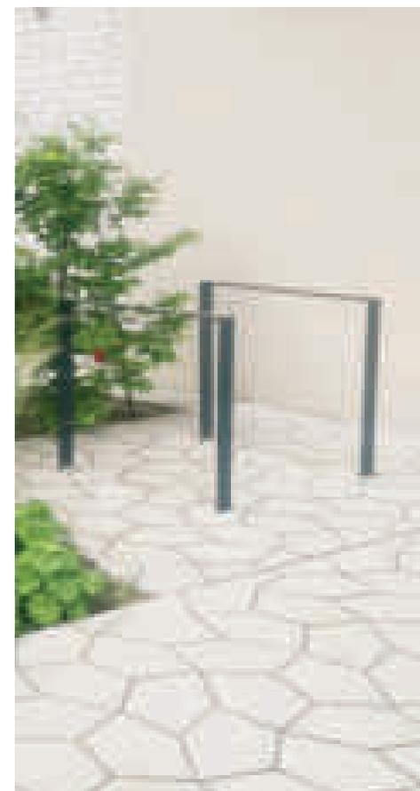
Abb. 113: Flachstahlfahrradbügel in Plattenbelag
