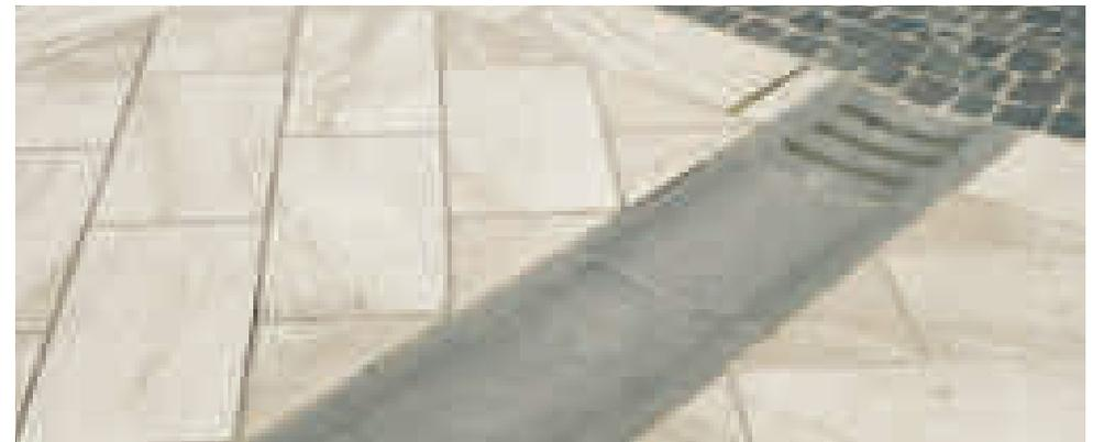
Abb. 107: Offene Entwässerung in hochwertigem Belag
